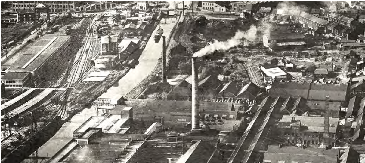
Détail de la vue aérienne de la faïencerie datant des années 1960 (© archives Keramis)
