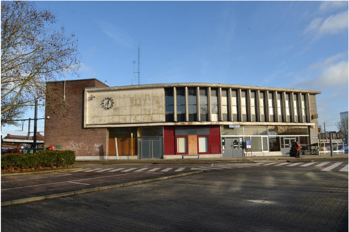
Vue extérieure de la gare de La Louvière-Centre (©Keramis)
